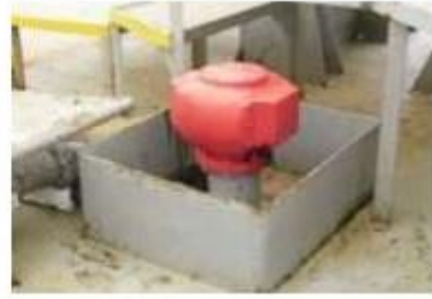
写真1 空気管頭の高さを考慮した艀装例
