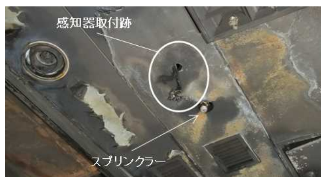
写真5 US室左舷側の天井
