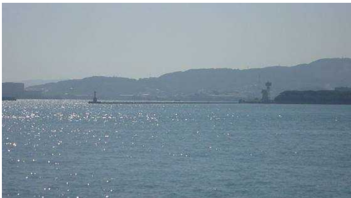
写真2 洞海湾口防波堤（北東方から撮影）
