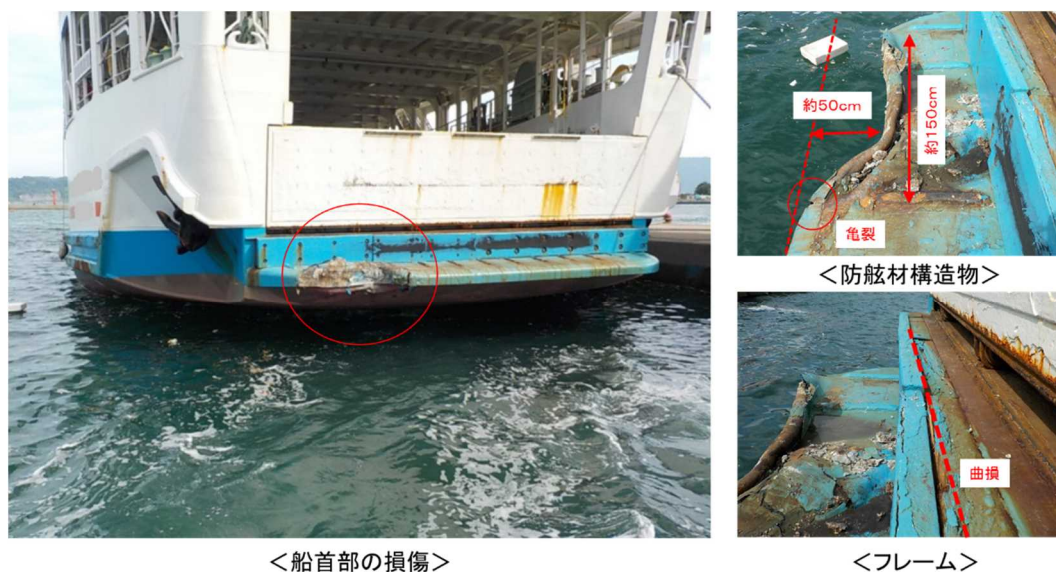
図3 本船の損傷状況
