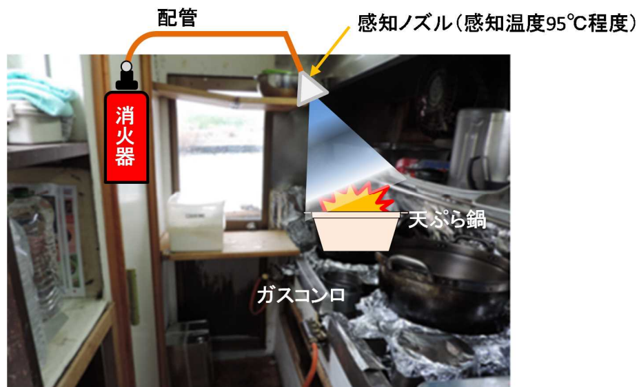
図8 自動拡散型粉末消火器のイメージ
