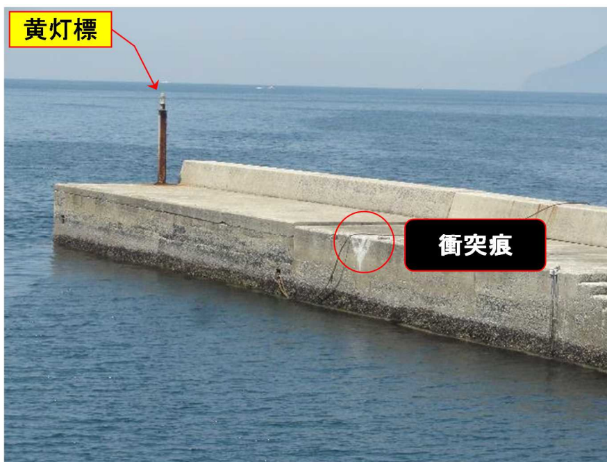
図2 沖防波堤の衝突痕
