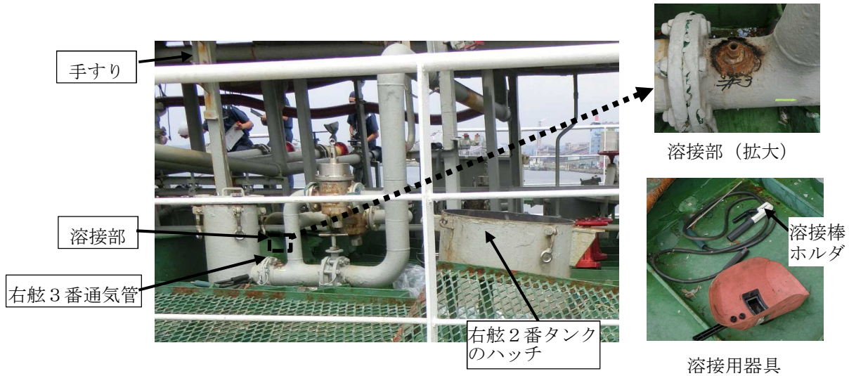
写真2.1 右舷3番通気管の溶接作業場所付近
