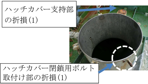
(右舷2番タンクのハッチの損傷状況)
