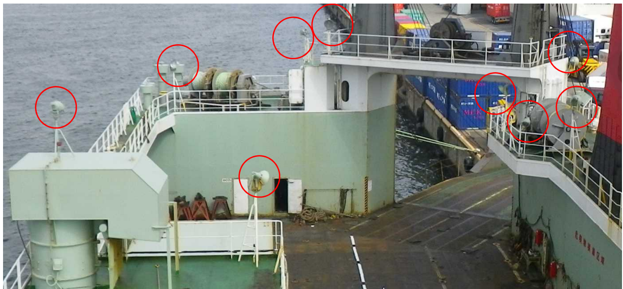
写真2.7-2 船橋後方の照明
