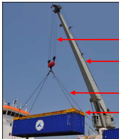
写真5 コンテナのつり上げの状況
