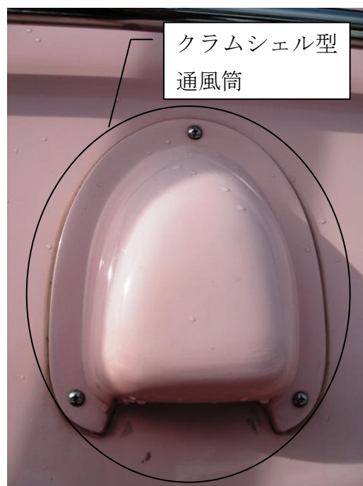
写真 1 2 通気口及びクラムシエル型通風筒の状況
