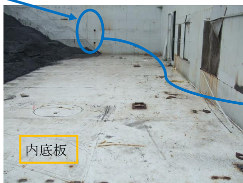
写真 2.6-8 2番貨物倉の船倉側壁に設けられた固定ピンの差込口(1)
