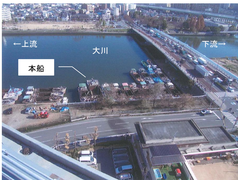
写真2.1 本事故発生場所の状況 (大阪市消防局撮影)
