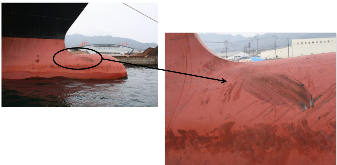
写真2-1 A船の損傷状況
