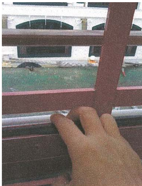
写真3 2階客室の上窓の開放状況
