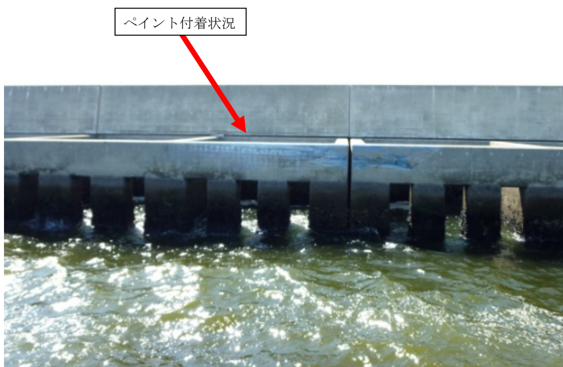
写真3 本件護岸の状況
