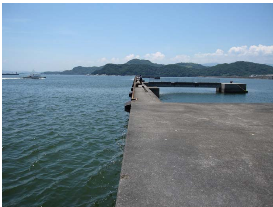
写真4 係船杭の状況
