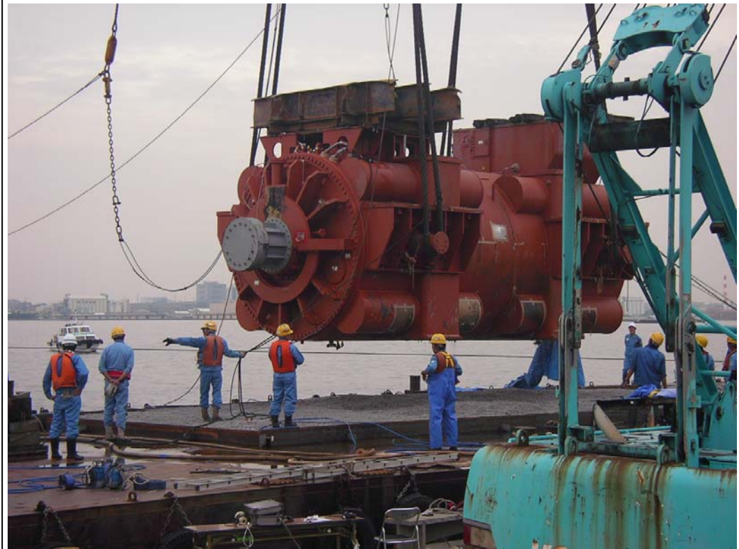
水没した本件貨物の引揚時
