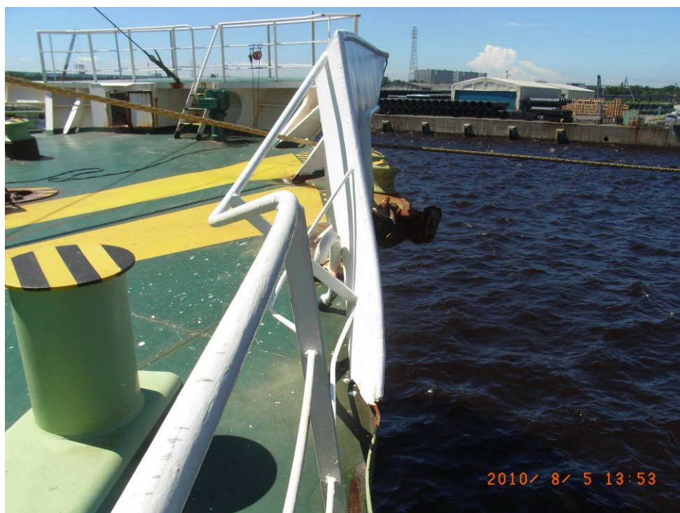
写真8 B船の損傷状況（前部その1）
