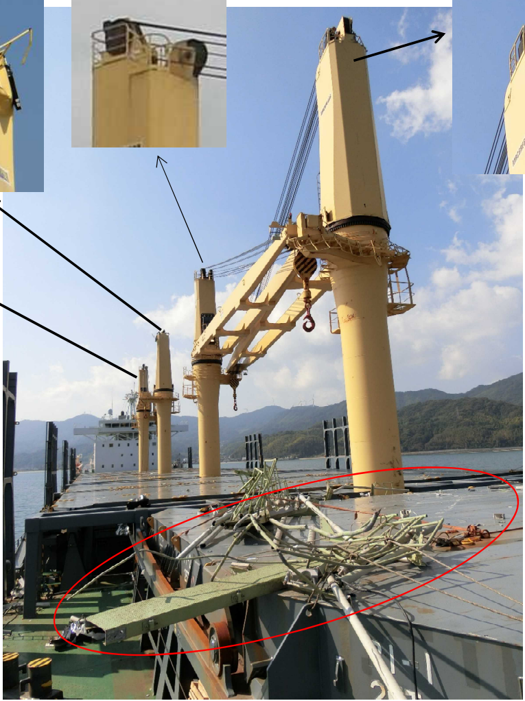
大島大橋から脱落した検査通路等
