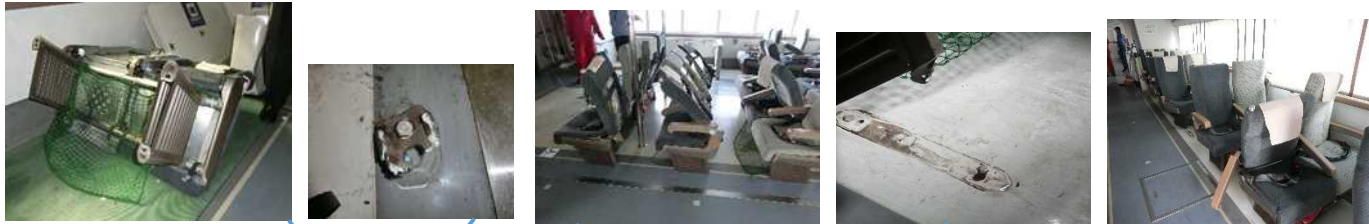
本船客室内の損傷状況(現場調査時)
