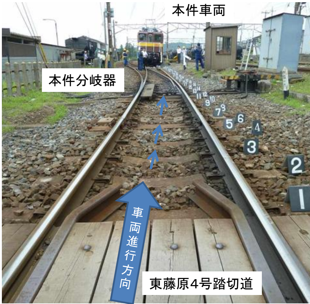
写真1 本重大インシデントの脱線現場
