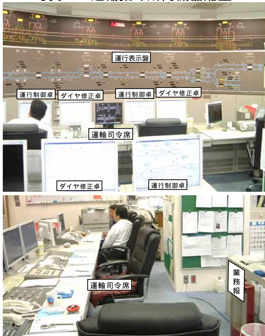
写真4 運輸指令所内機器配置
