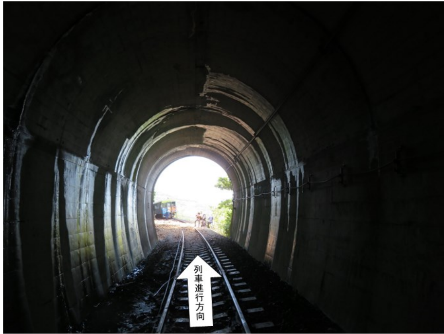
図3 本件トンネル内から見た列車進行方向の見通し状況 (土砂等から約30m手前)(事故翌日)
