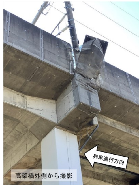
第7大平高架橋 R3・防音壁 (左側) 脱落
