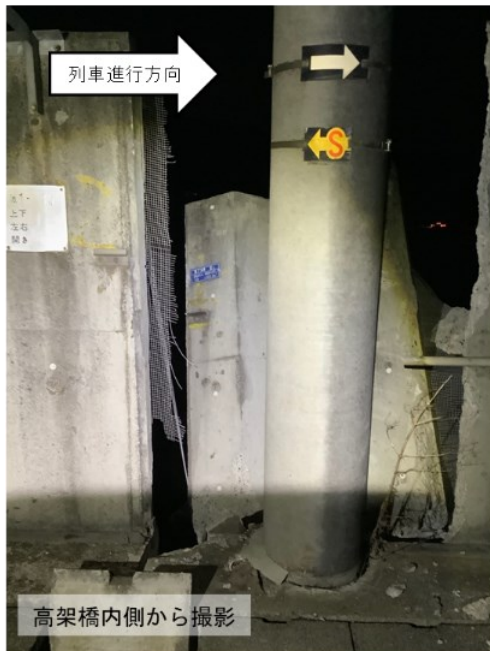
第7大平高架橋 R3・防音壁 (左側) 脱落
