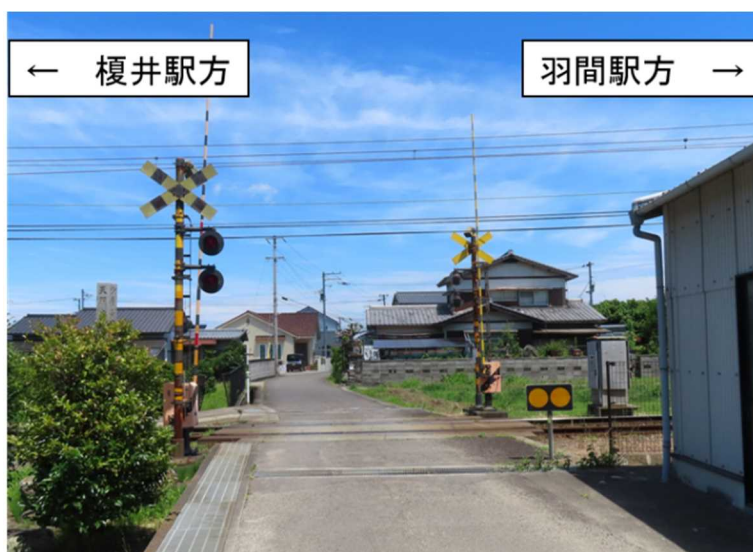
図6 南側から見た大橋踏切道の状況
