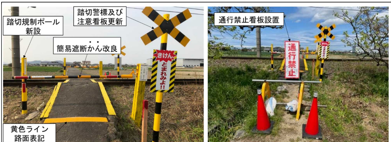
図8 本事故後の本件踏切の状況
