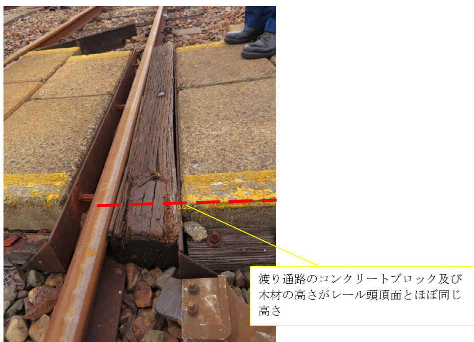
図2 渡り通路の敷設状態
