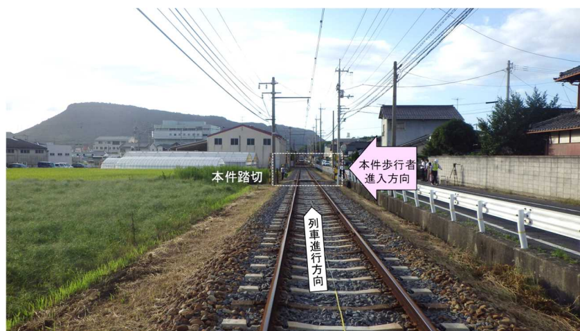
図4 上り列車側から見た本件踏切の見通し状況
