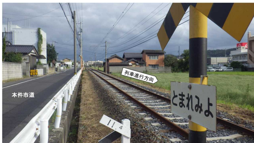
図5 本件踏切からの大町駅方の見通し状況
