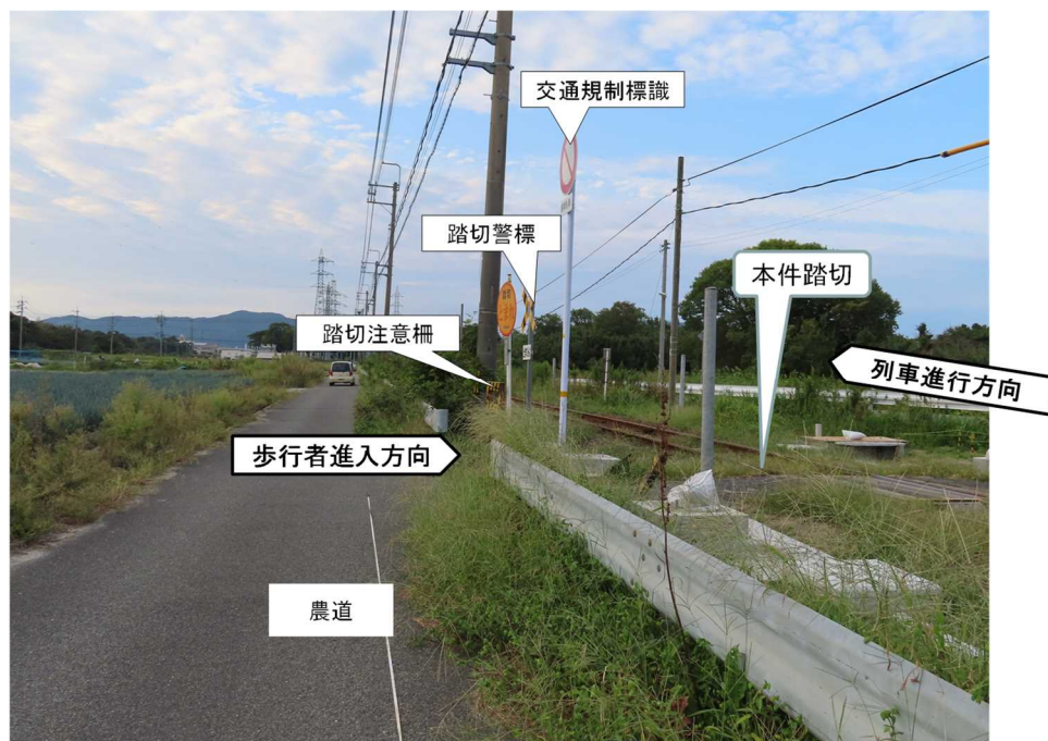
図4 本件踏切の状況（中浜駅方から撮影）
