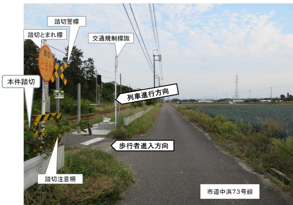
図5 本件踏切の状況（高松町駅方から撮影）
