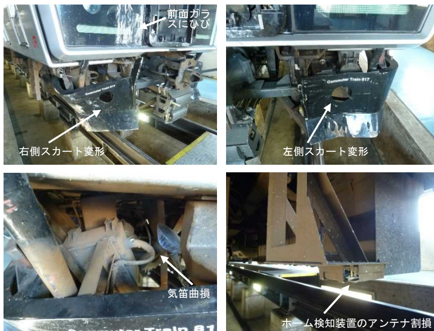
図10 先頭車両の主な損傷状況
