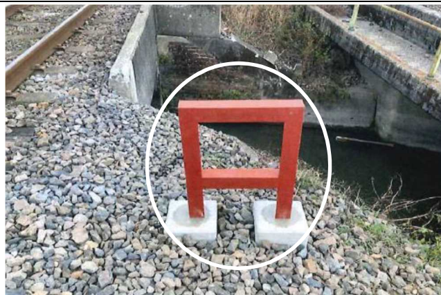
図16 設置された転落防止柵
