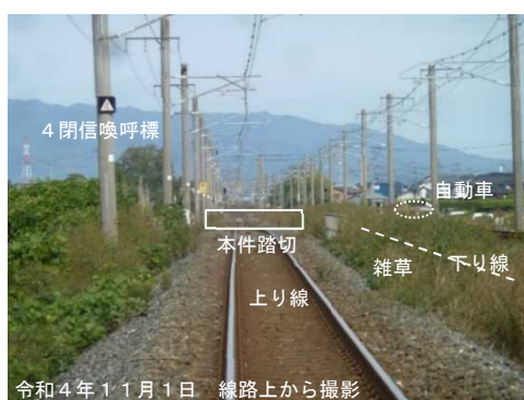
図6 列車側から見た本件踏切の見通し状況
