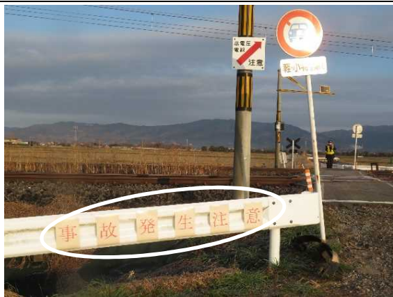
図15 注意喚起板の設置
