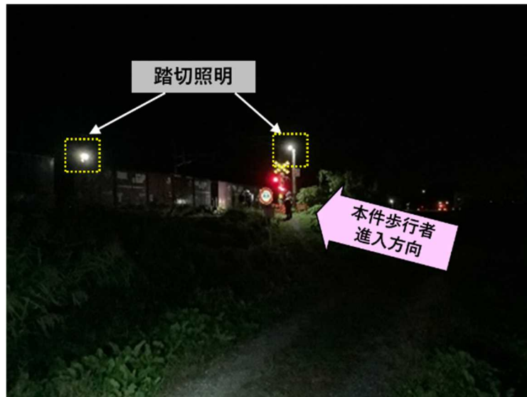
図5 本件歩行者進入側から見た本件踏切の状況（本事故発生直後の夜間）
