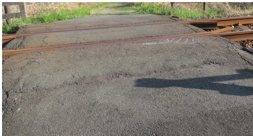
図4 本件踏切内の路面の状況
