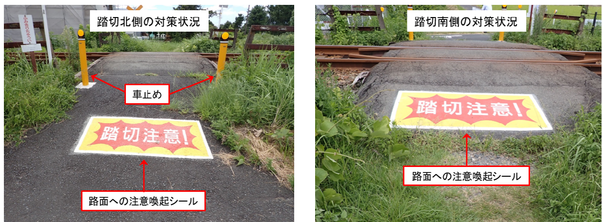
図8 本事故後の本件踏切の対策状況
