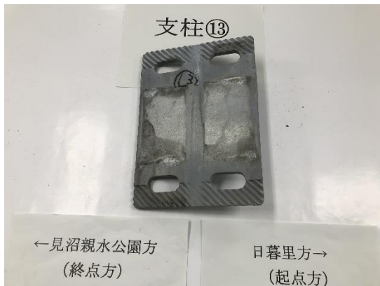
(a) 損傷なし (支柱⑬)
