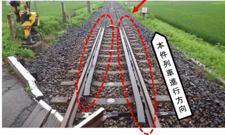
図7 脱線防止ガード及び監視カメラの設置状況
