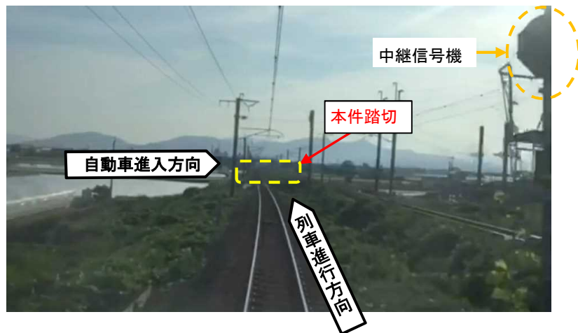
図5 列車から見た本件踏切の見通しの状況
