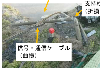
支持柱及び信号・通信ケーブル損傷
