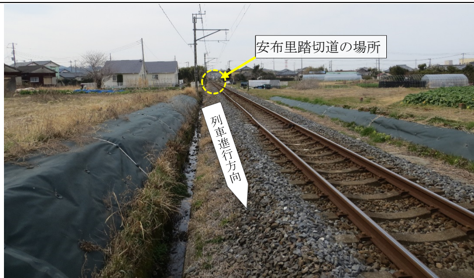
図3 本件踏切からの列車見通し状況
