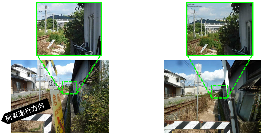
[a]踏切警標直前（線路中心から約4.5m） [b]踏切警標直後（線路中心から約4.0m）
