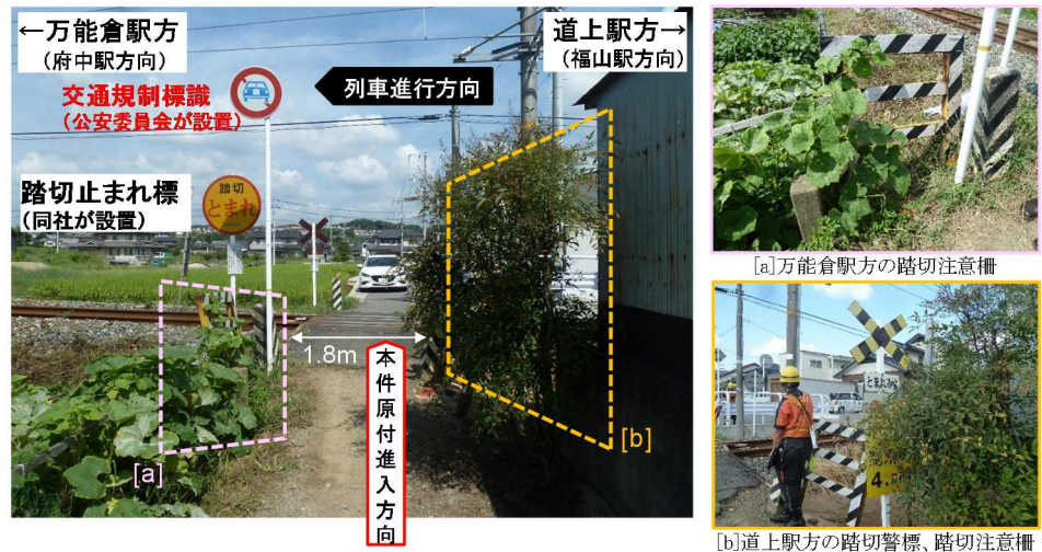
写真1 本件原付進入側から見た本件踏切の状況
