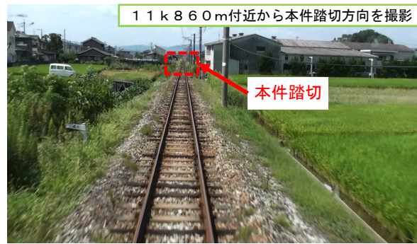
写真6 本件列車側（下り列車）から見た本件踏切の見通し状況
