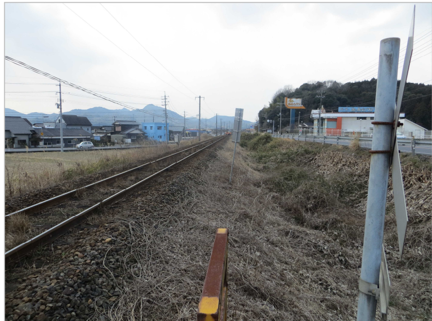
写真2 本件通行者進入側柵位置付近での見え方
