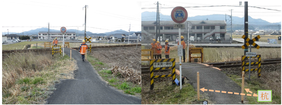
写真1 本件通行者進入側から見た本件踏切の状況 (本事故発生日翌日に撮影)
