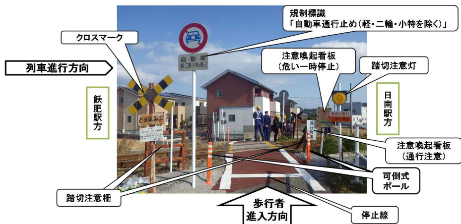
写真1 本件踏切の概観（歩行者進入側から撮影）
