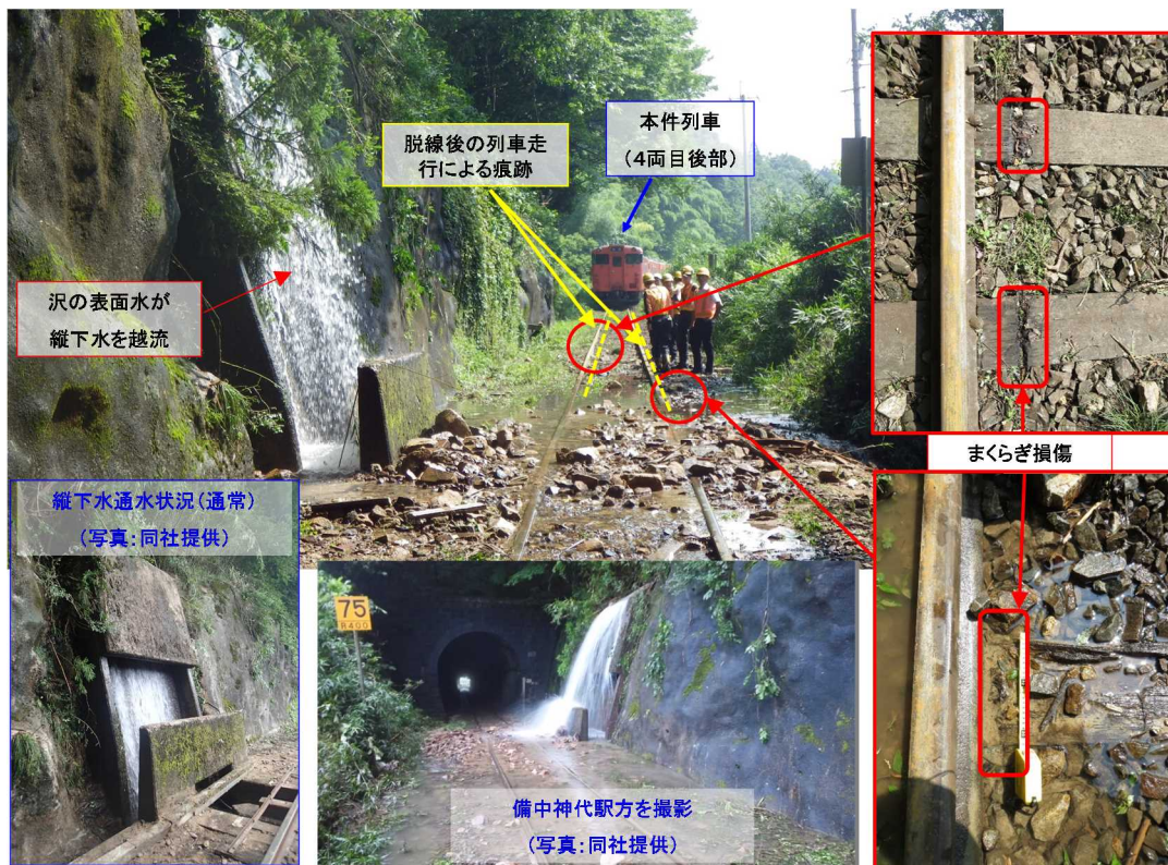
付図4 事故発生場所付近の状況及び軌道の主な損傷状況
