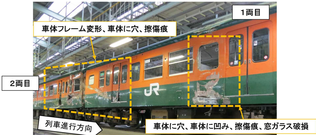
写真4 車両右側の側面の主な損傷
