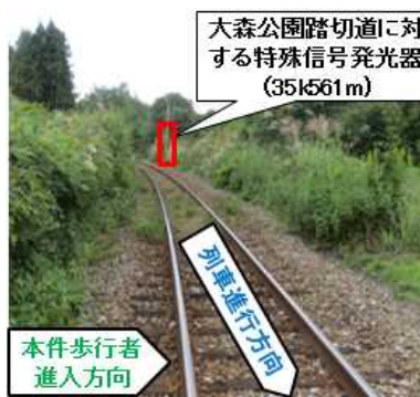
本件踏切の右レール付近から城野駅方を撮影
