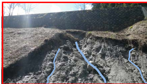
崩壊した斜面内部からの流水
