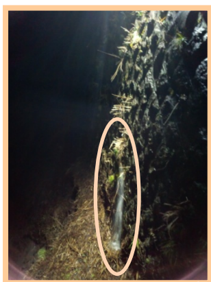
排水パイプより 勢いよく流れて いる水 (事故直後)
