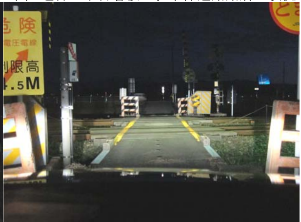
(c) 踏切道の状況
