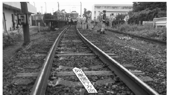
脱線車両の移動後の軌道 (2k207m付近)
