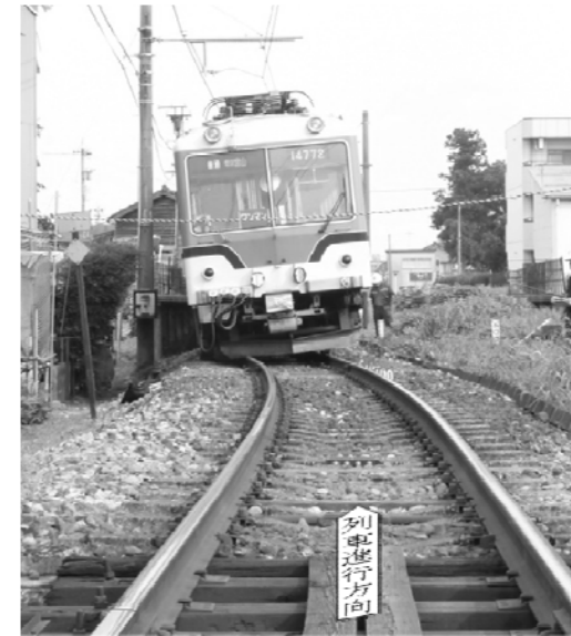
岩嶮寺駅方より現場を見る
