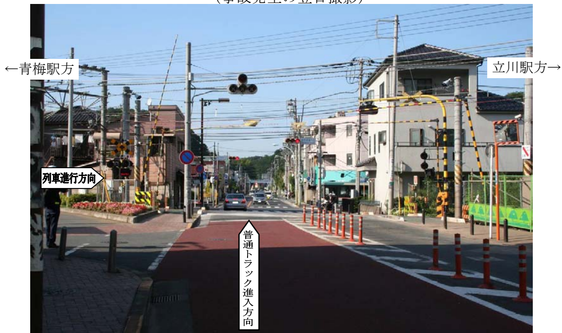
写真1 道路側から見た本件踏切の見通し状況 (事故発生の翌日撮影)
