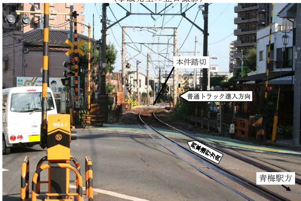
写真2 列車側から見た本件踏切の見通し状況 (事故発生の翌日撮影)
