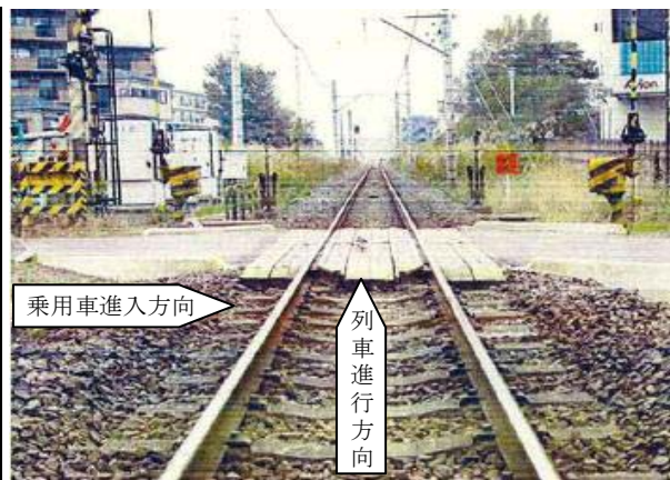
列車進行方向からみた状況
