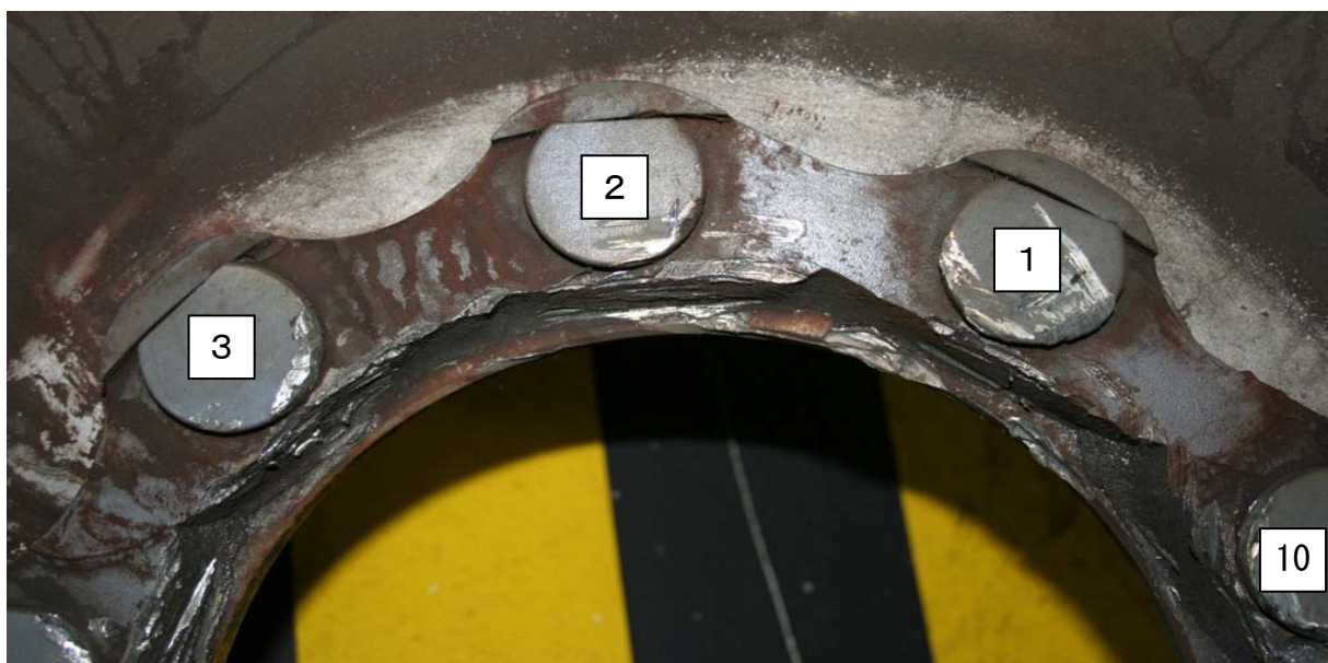
付図10 本件ハブの状況・フランジ側（その2）
