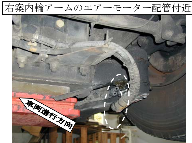
右案内輪アームのエアーマーター配管折損 及び近接スイッチの配線切断
