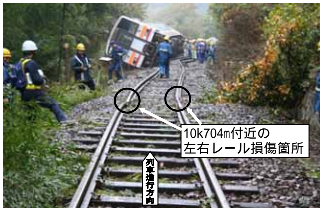
写真2 脱線現場の軌道状況
