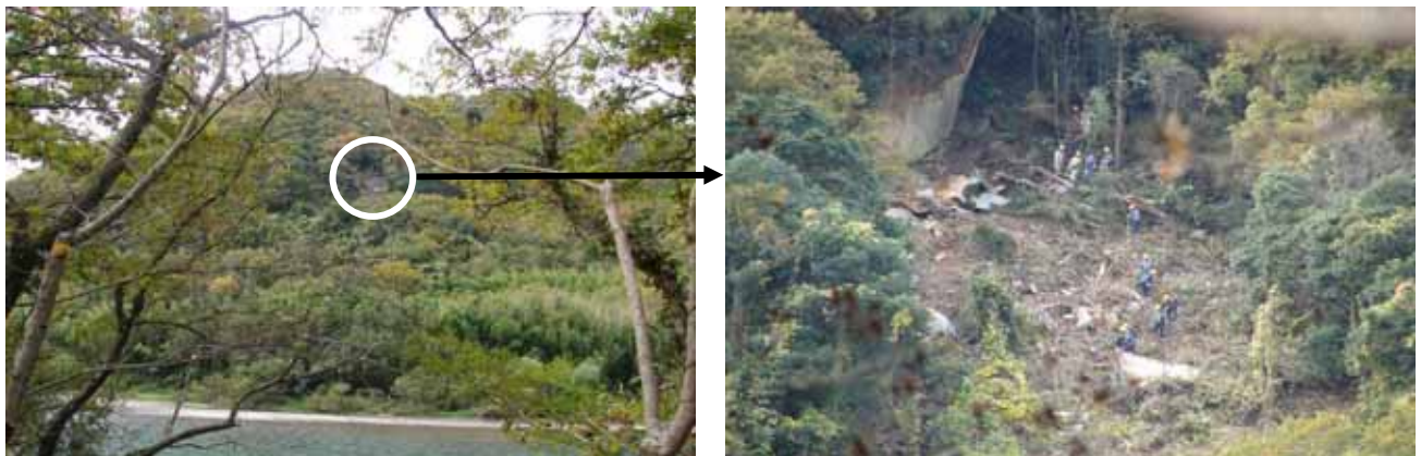
写真5 本件崩壊箇所の状況
