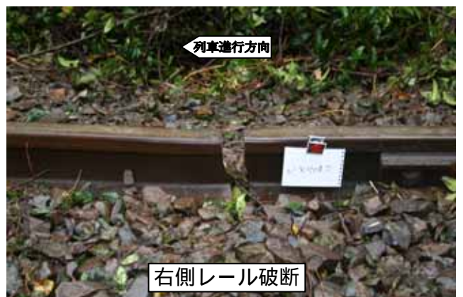
写真3 10k704m付近のレール損傷状況
