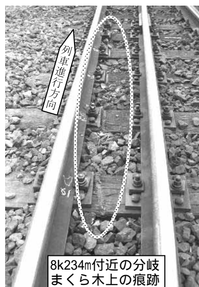
写真6 軌道の損傷状況
